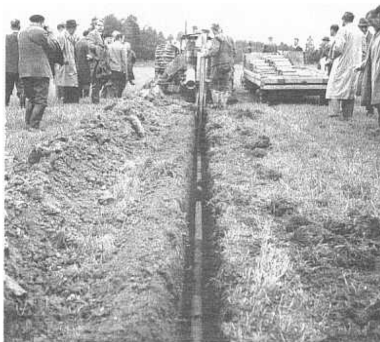
Från exkursionen i Värmland 1961. Man studerar maskinell täckdikning med direktläggning av tegelrör.
